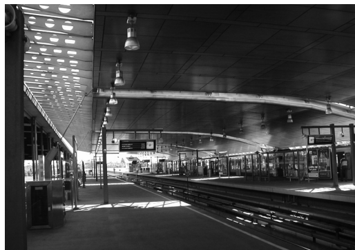
XIV-13. Dworzec Schiedam Centrum (2002) – wnętrze hali metra. Po lewej widoczne ciągnia przeciwdziałające podrywaniu dachu podwieszzonego fot. autora, 2008, CC
