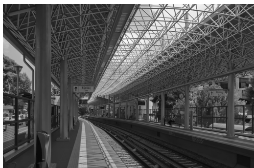
XIV-25. Stacja metra Irákleio koło Aten – widok hali. Podparcia punktowe, elementy kratownicy przy słupie pogrubiłone fot.: Trowbridge Estate, 2012, CC
