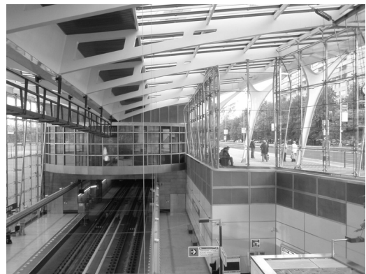
XIV-16. Praga, stacja metra Střížkov – wnętrze hali fot. autora, 2008, CC
