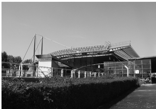
XIV-12. Dworzec Schiedam Centrum (2002) – widok dachu nad peronami metra fot. autora, 2008, CC
