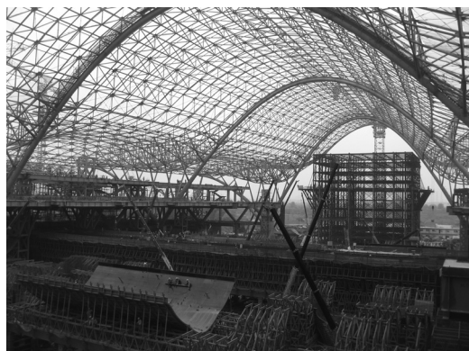
XIV-27. Dworzec Wühan – hala w budowie
